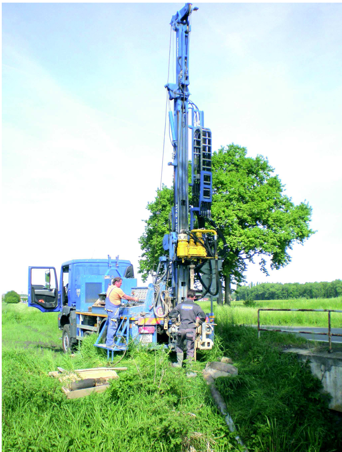
Obr. 2 Pohled na soupravu HVS-4100/Man při realizaci vrtu J 1 na pravém břehu Bačovky.
